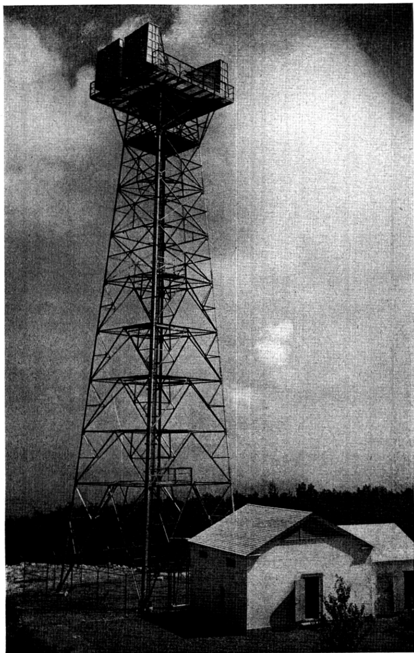
Fig. 6—125 foot steel tower.
